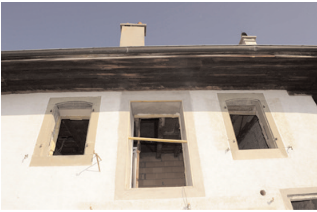
Dans l'appartement du haut, création d'une nouvelle ouverture verticale.
