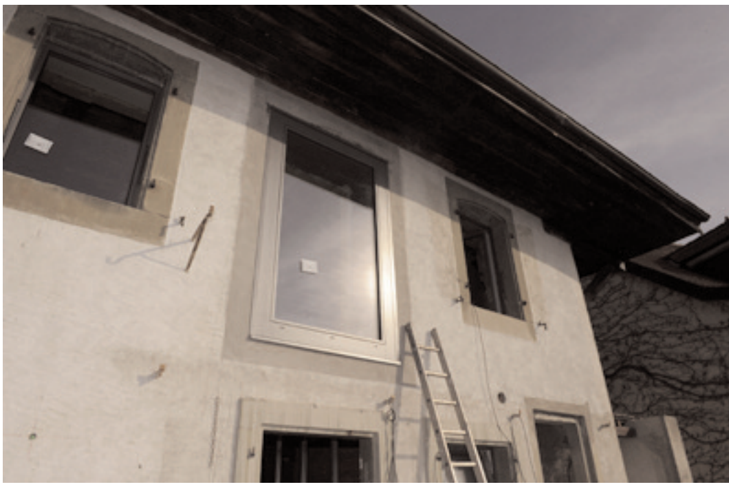
La nouvelle fenêtre, une fois posée.
