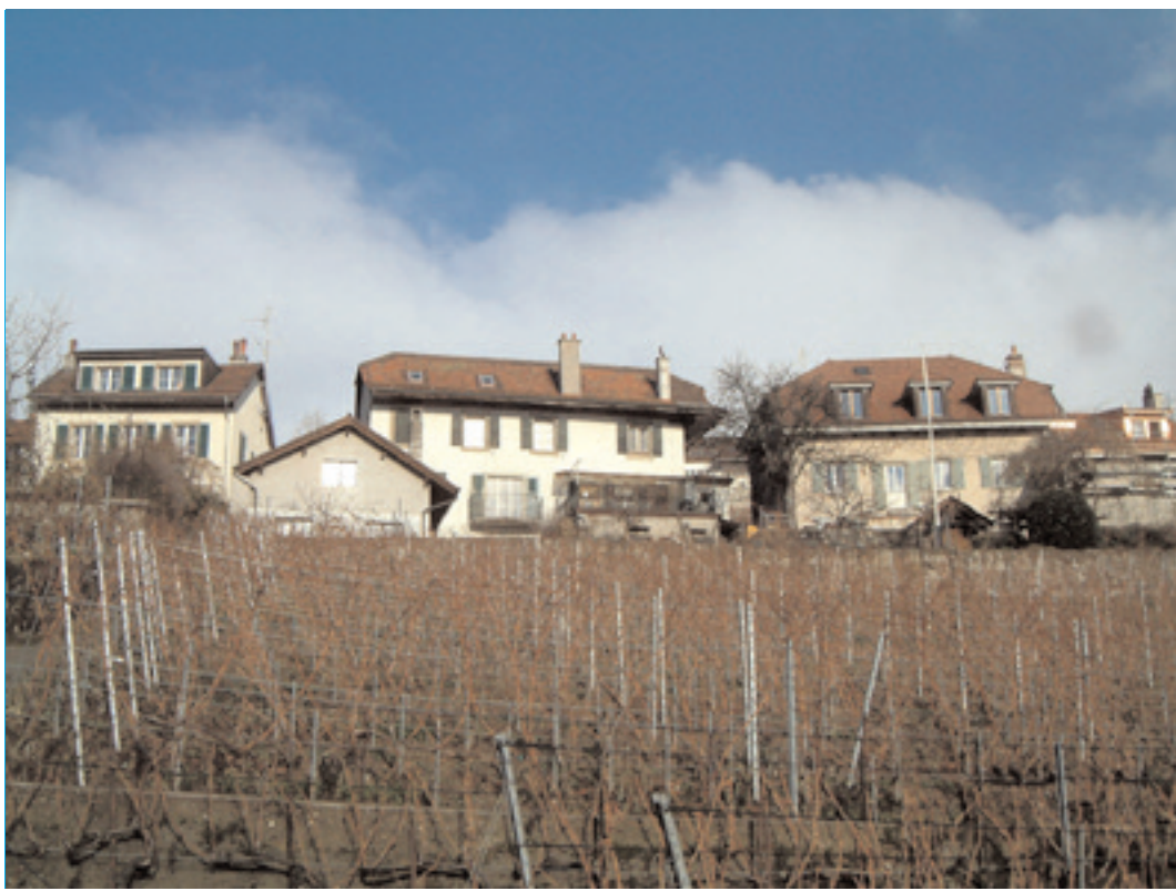
Avant les travaux, la maison vigneronne (façade blanche) avec le balcon et la terrasse.
