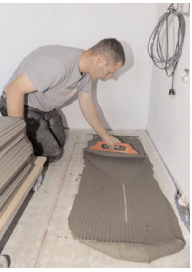
Pose des carrelages dans l'appartement du haut.
