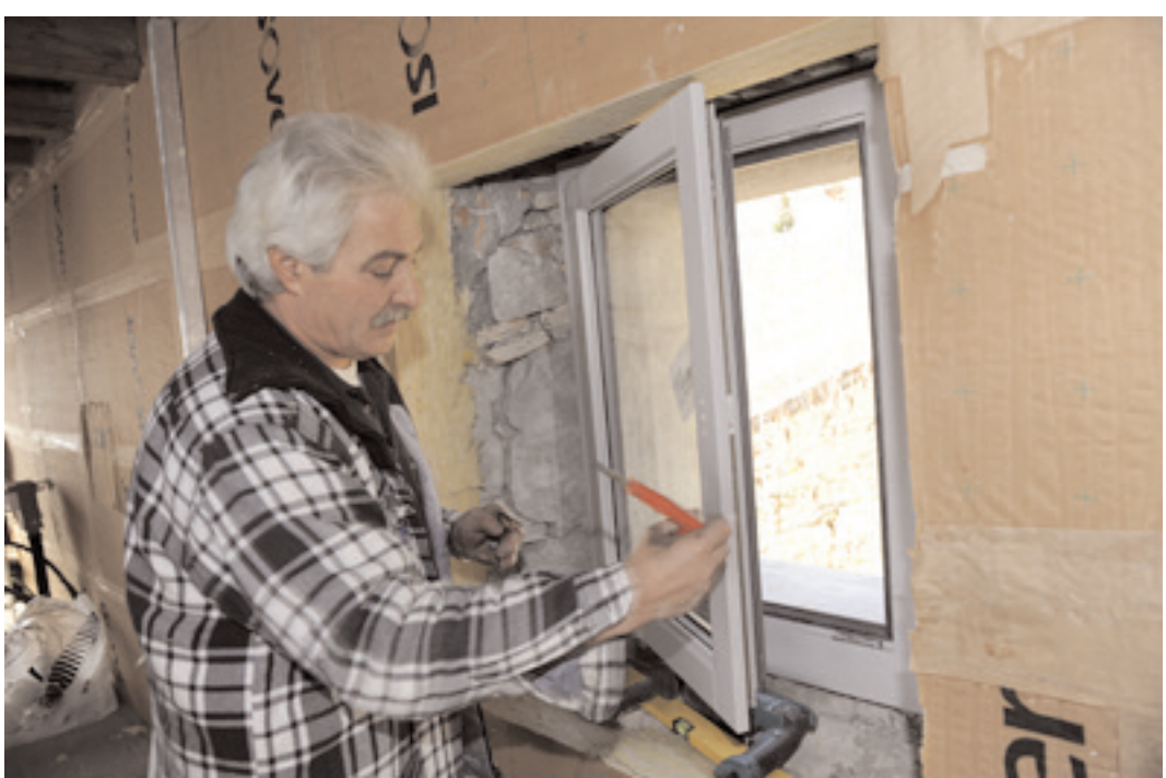
Pose des nouvelles fenêtres.
